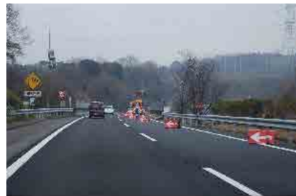
工事規制箇所では早めの車線変更を
